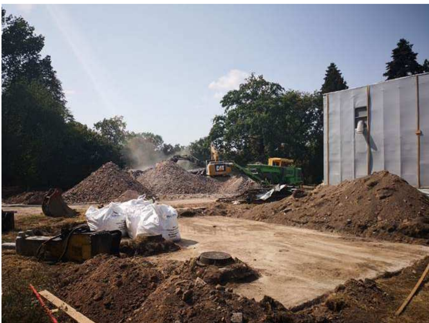
Obr. 13: Demolice objektu ze 70. let 20. století v provádění. Třídění a ekologická likvidace stavebního odpadu.
