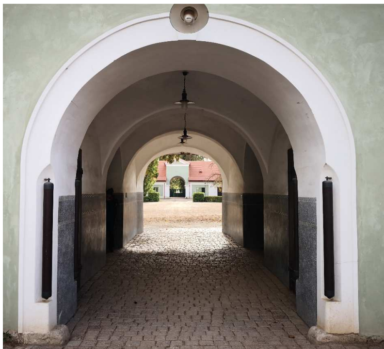
Obr. 10: Tzv. rolny, tj. otočné dřevěné válce umístěné na rozích portálů stájí.
