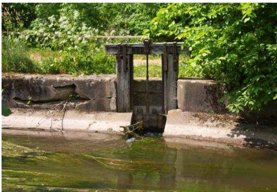
Obr. 23: Hradítko upravující přítok vody z Opatovického kanálu do Kladrubského náhonu zásobujícího krajinu vodou.
